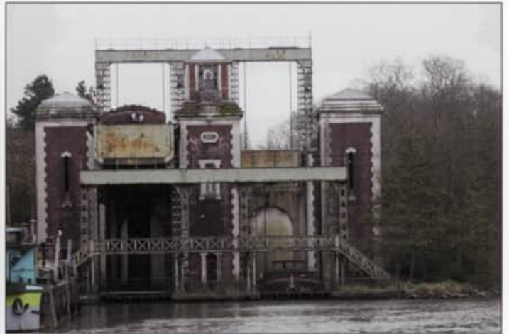
29.4. England wird ersatzlos gestrichen! Zu sehen: Alte Schiffschleuse von Arques am Canal de Neuffossé..
