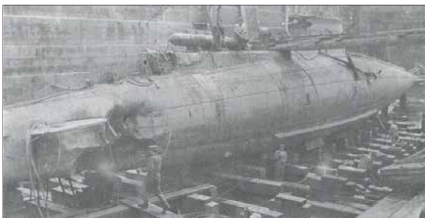
B10 im Dock in Venedig nach der Bergung am 23. August 1916. Aus dem Vergleich mit den Personen ist der Leckbereich rund 2x2m groß (Foto: Museo storico navale Venezia)
