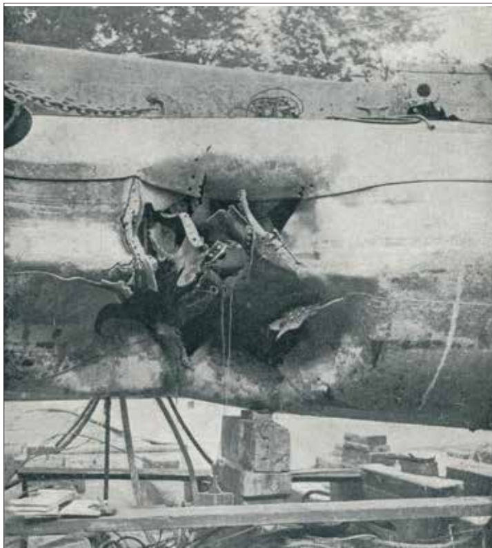
Das Leck im Backbord-Vorschiff von B10 verursacht durch eine 20kg k.u.k. Bombe (aus: Guido Milanesi, Submarines).
