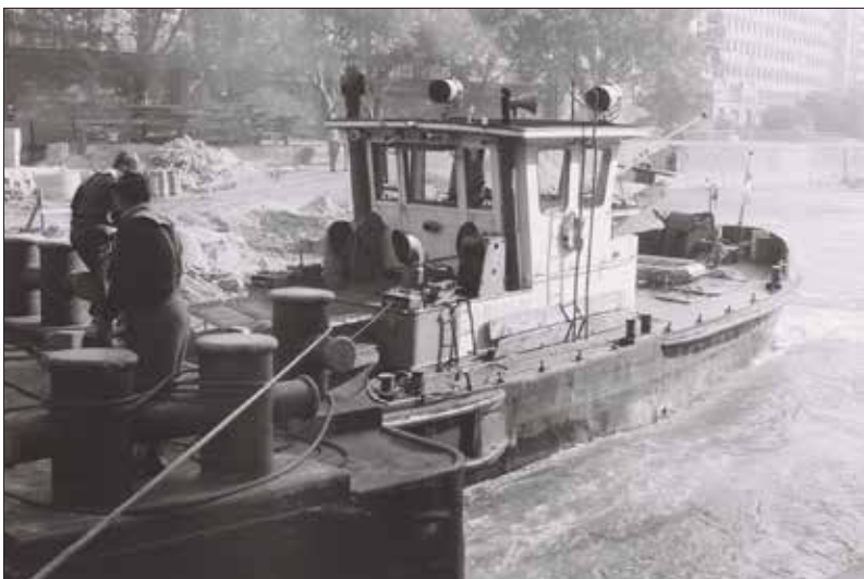
GNOM mit einem Schubleichter im Bereich der U-Bahnbaustelle.
