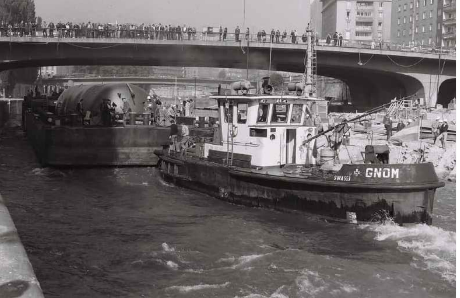
GNOM dockt an einem DDSG-Leichter, beladen mit einem Schwergut-Druckbehälter, im Bereich der Baustelle U1, Schwedenplatz, an.
