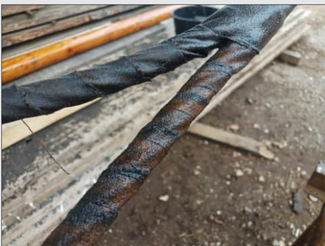
Mit Labsal (traditionelle Mischung von Holzteer und Leinöl) getränk- te Stoffstreifen werden über die bekleedete Stelle gewickelt.
